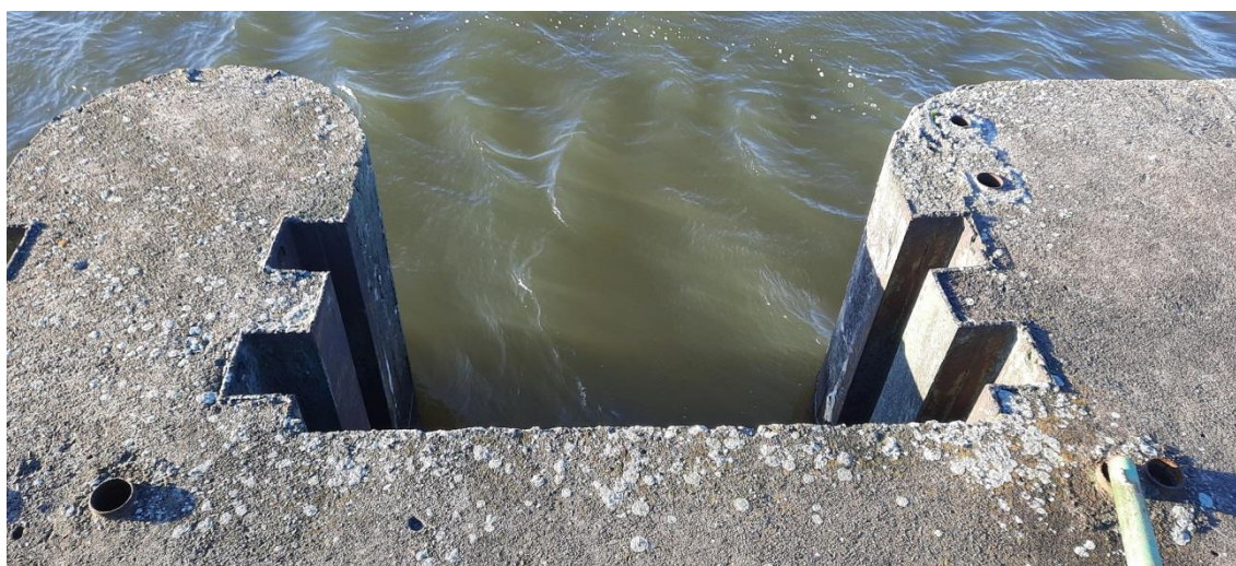
Drážky pro osazení revizních tabulí
